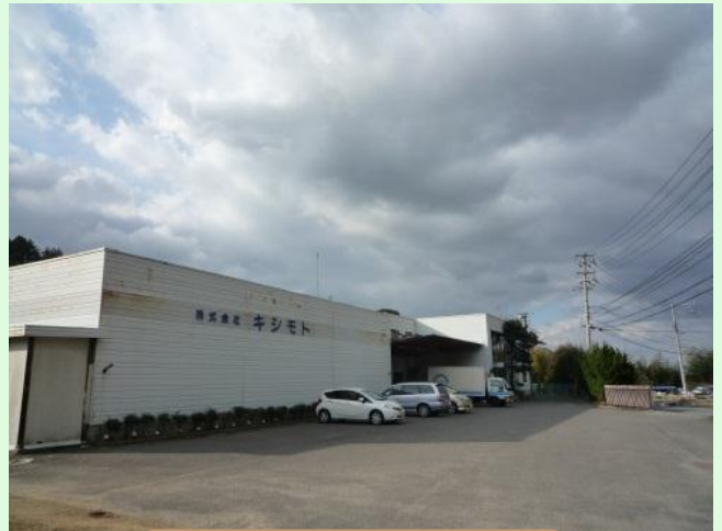
キシモトの本社・工場
