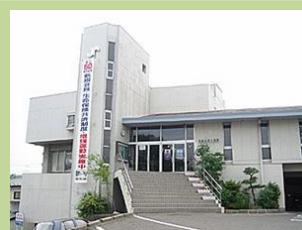
須賀川商工会館
