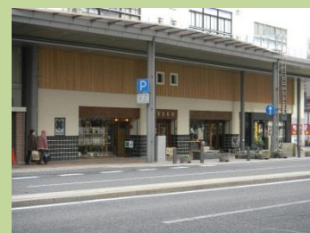
グループ補助金活用で復旧した菊屋ビル
