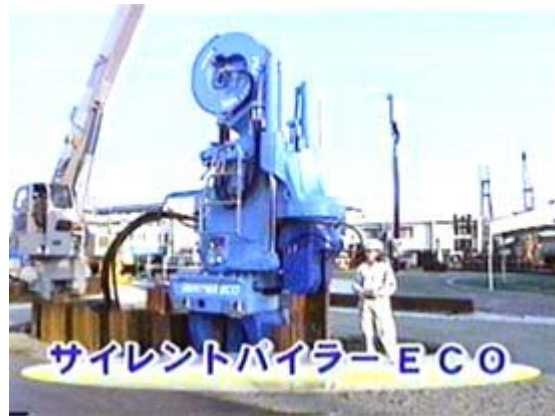
「サイレントパイラー」
