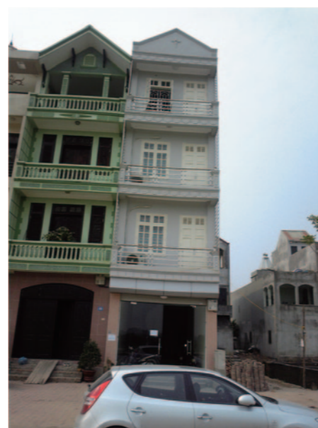
現事務所外観
