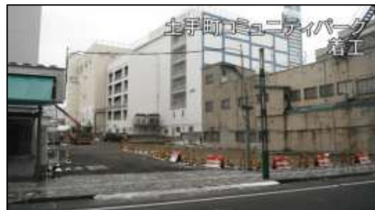
DCP 着工当時の様子
