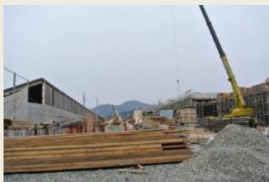
工事が進む仙崎魚市場。 左側は現在の魚市場
