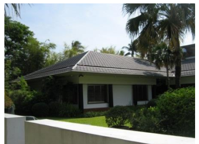
フィリピン 石州平板瓦施工例
