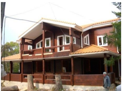
ロシア 石州洋瓦施工例
