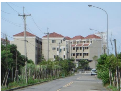
台湾 石州洋瓦施工例
