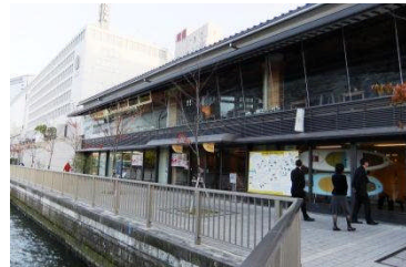
整備された八軒家浜船着場の川の駅
