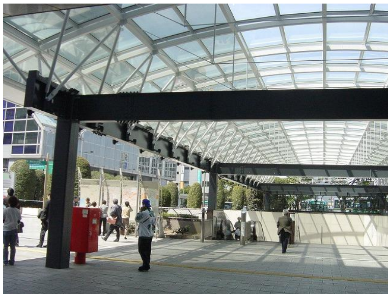
浜松駅北口駅前広場（静岡県浜松市）：シェルター
