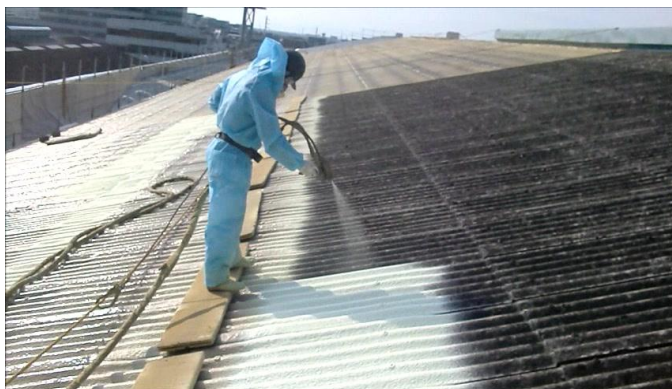
<蘇生工法の施行作業の様子>
