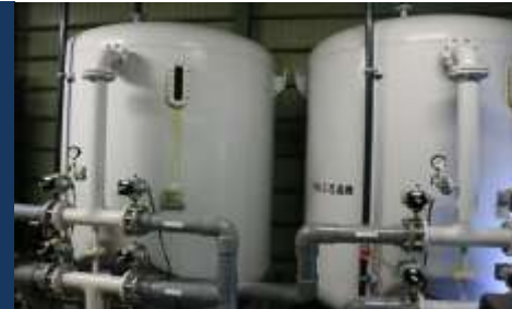
井水利用による洗米用水を確保した米業工場
