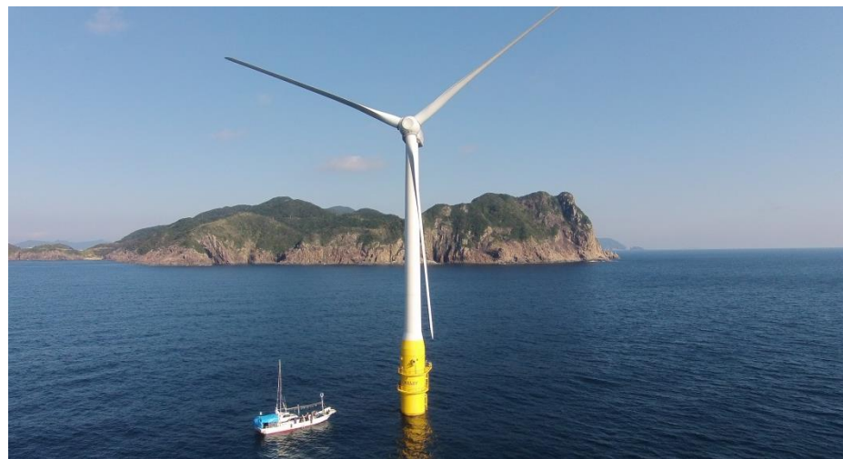
五島市柁島沖 洋上風力発電
