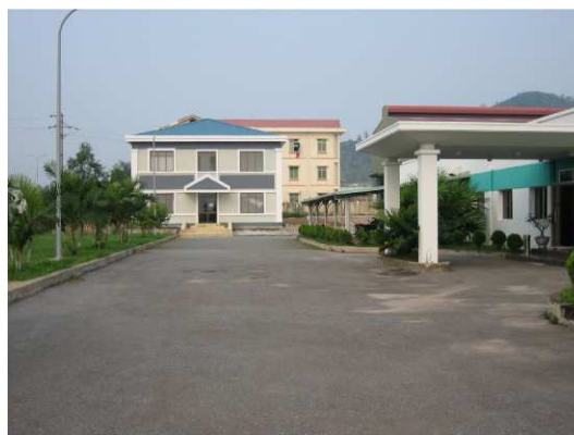
敷地内にある従業員寮
