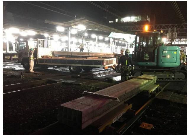
軌道内資材搬入状況
