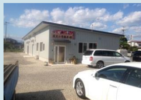
復旧した本設工場
