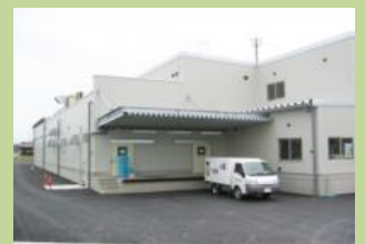
グループ補助金と借入金により再建した新工場が稼働開始 (2013年3月)
