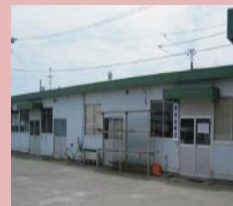
プレハブ仮設にて営業再開
