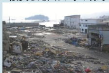
被災した山田町の様子
