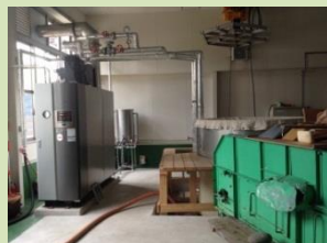
復旧した製造現場
