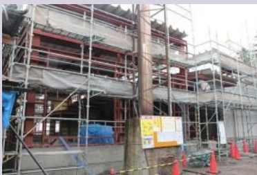
建設中(当時)の新蔵
