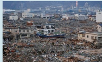
大船渡市大船渡地区の被災状況
