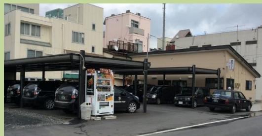
復旧後の新社屋
