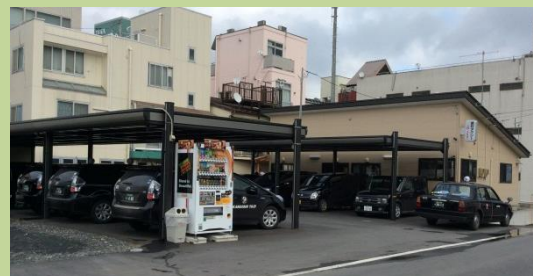
復旧後の新社屋
