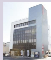
ダイマルヤビル
