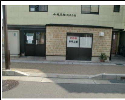
小麦工場とは道路を隔てた別棟の専用工場
